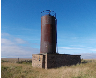
Figura 1.14 Tanc de combustible
