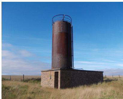
Figura 3.1 Tanc de combustible
