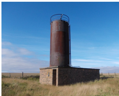
Figura 7.8 Tanc de combustible
