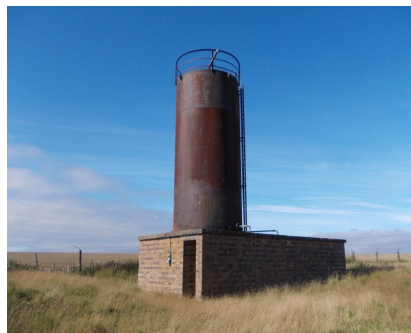
Figura 65 Tanc de combustible
